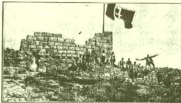
Las fortificaciones construidas en Roma, sobre la cima del Monte Mario.
